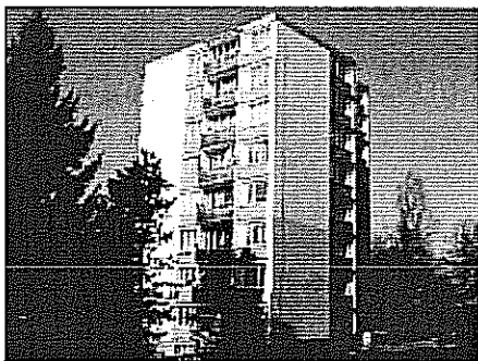
Pohled z číselníku panelů ulice SNP od východu
