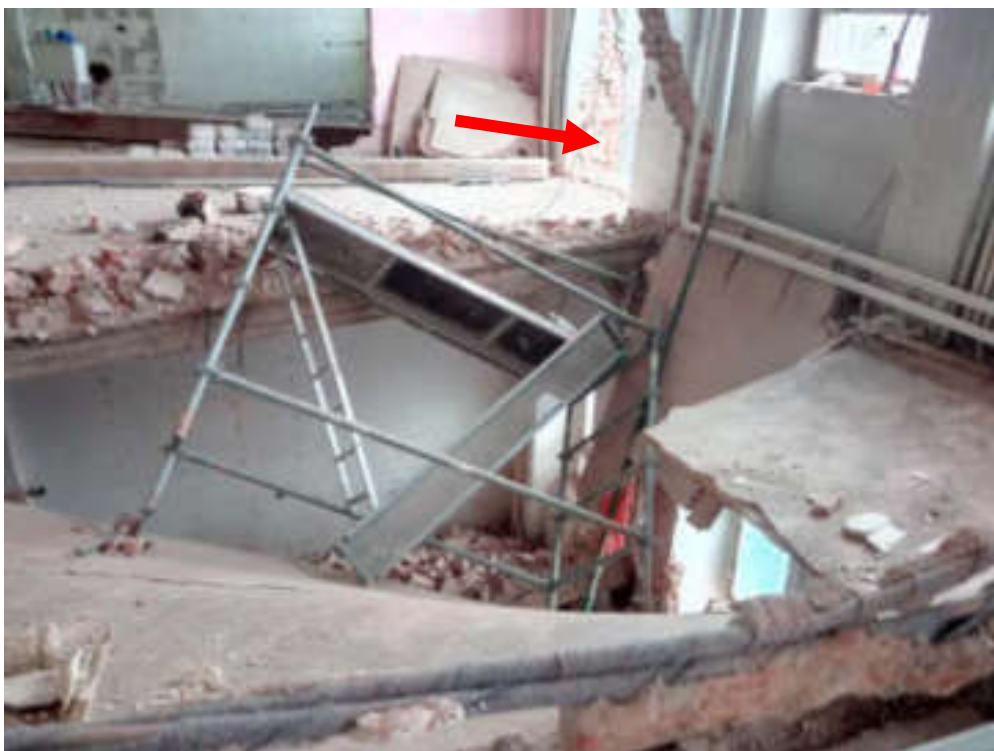
Havárie stropu, na kterém bylo umístěno lešení. Na obrázku vyznačen prostup obvodovou zdí, kde se vyklízela suť v 2.NP.
