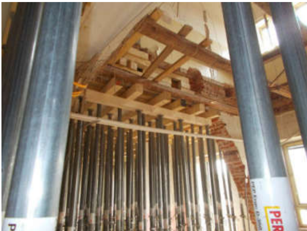
Podchycení nosné zdi ve 3.NP. Pohled z 2.podlaží.
