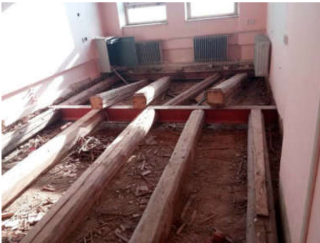
Dřevěné stropnice byly vsazeny do ocelových nosníků na spodní pásnici.
