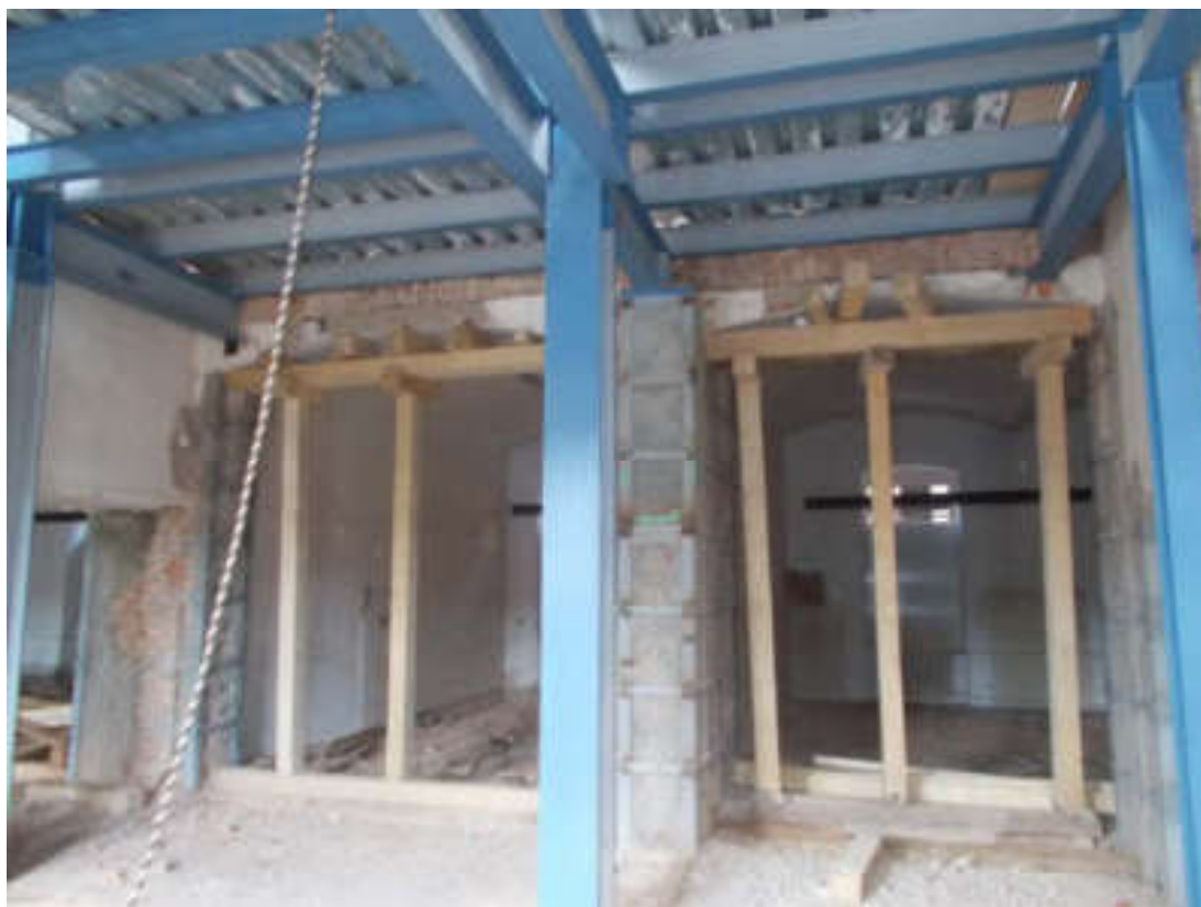
Ocelová konstrukce se stropními trapézovými plechy, zesílení zdiva pásovinou.
