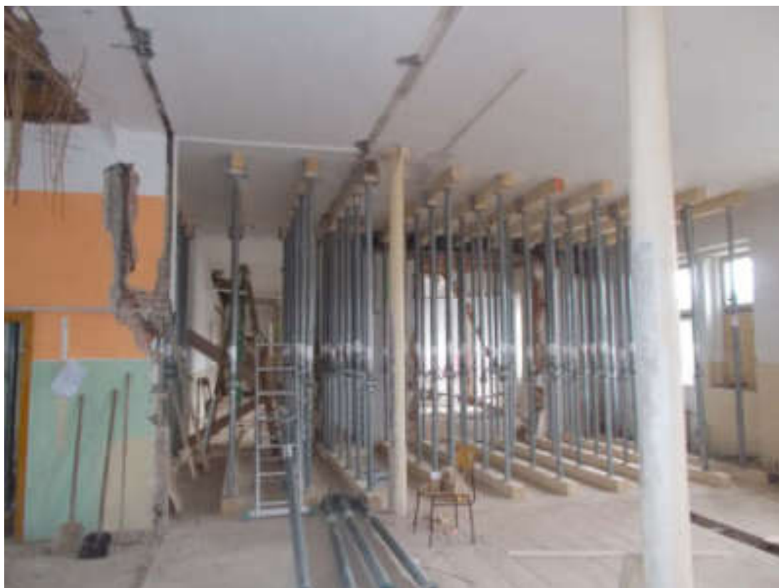
Provedené podchyení v 2.NP. Podchyení stropu nad 2.NP.
