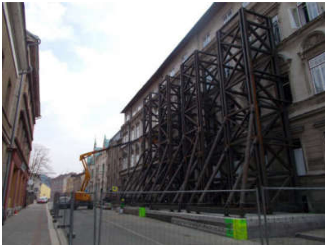
Statické zabezpečení budovy č.p.717 v ulici Podhorská.
