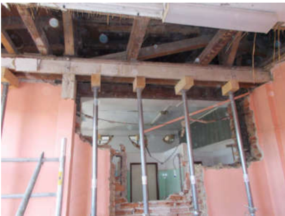
Podchyzení krovu střechy.
