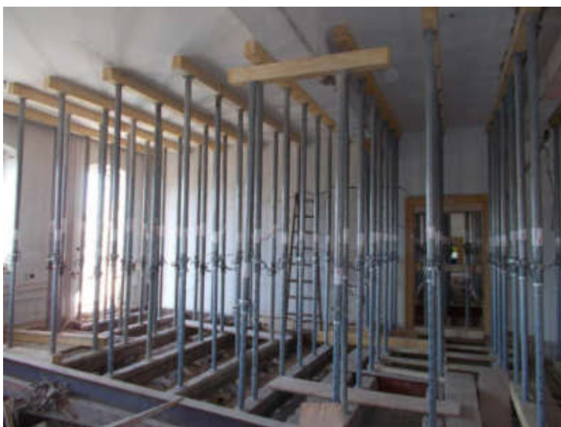
Podchycení stropů u nosné zdi v místě havárie ve 3.NP.
