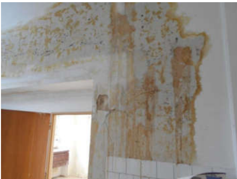
Stěna oslabena nikou. Pilíř zdiva u střední nosné podélné zdi, ve kterém jsou provedeny komínové průduchy.
