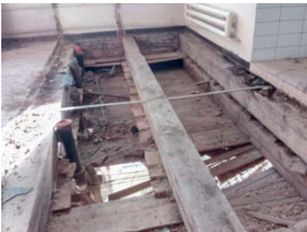
Skutečně provedené prostupy pro ZTI a kanalizaci, fotodokumentace pro místní šetření.
