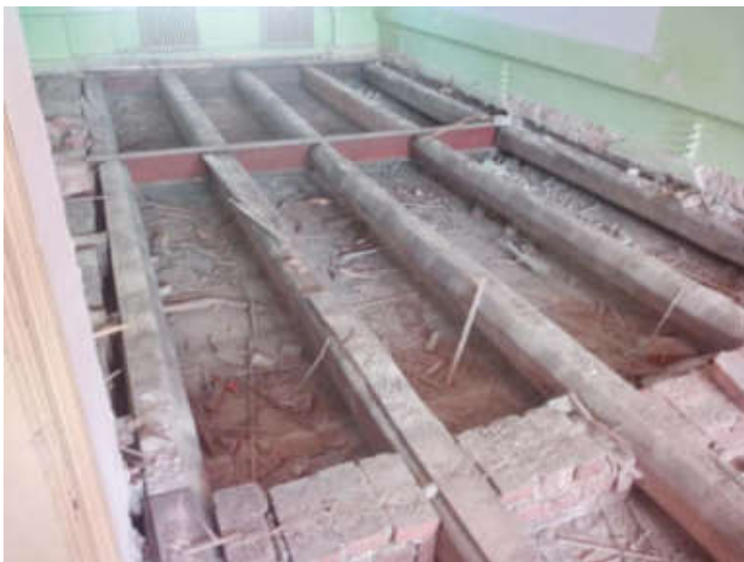
Dřevěné stropní trámy vynášené kovovými stropními nosníky. Dřevěné trámy jdou kolmo k obvodové zdi.
