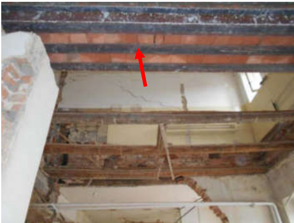
Pohled z 2.NP do 3.NP. Ve 3.NP bylo u střední zdi osazeno umyvadlo. Ve vedlejší stěně byly nad otvorem osazeny tři ocelové nosníky I. Nosníky na spodní pásnici byly opatřeny plnými pálenými cihlami.
