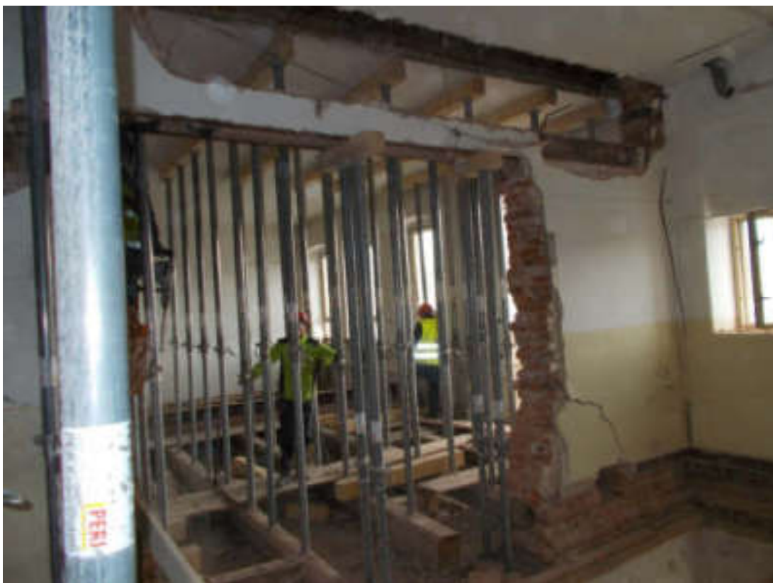
Vybourání poškozené nosné příčky ve 3.NP.
