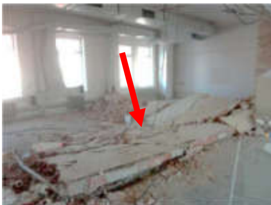
Stržená příčka na strop.
