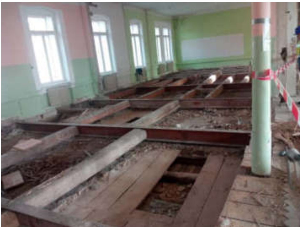
Dřevěné stropní trámy vynášené ocelovými stropními nosníky. Dřevěné trámy rovnoběžně k obvodové zdi. Nosný systém stropu měl být zjištěn u všech místností. Pod stropními trámy záklop, rákosníky a podbití s omítkou, část uliční.
