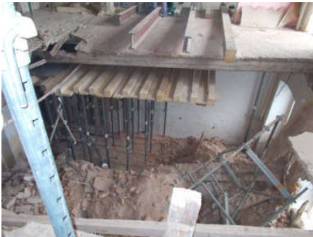
Postup podchyení stropních konstrukcí nad 1.NP.
